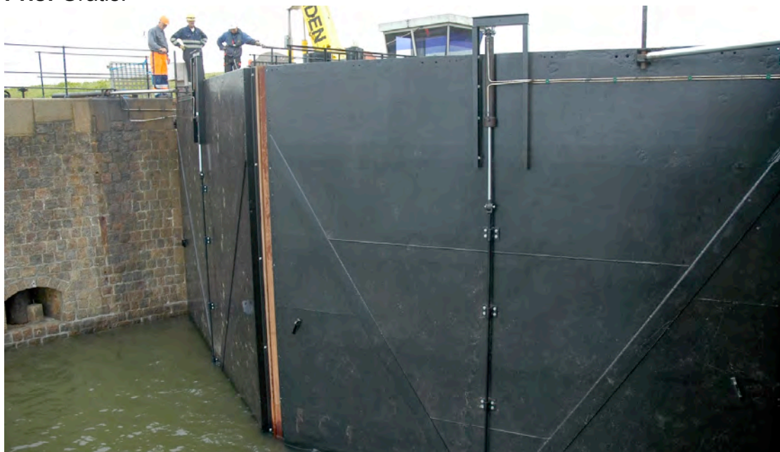
Ribe Kammersluse fik renoveret de yderste stormporte i 2009. Vægt pr. stk. ca. 16 t.
